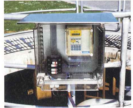
Parafoudre au plus près du capteur.
